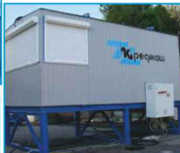
Асфальтосмесительной установкой управляет компьютерная система распределенного типа с выносными шкафами, оснащенными встроенной системой климат-контроля. Все электрооборудование выполнено на базе комплектующих европейских производителей.
